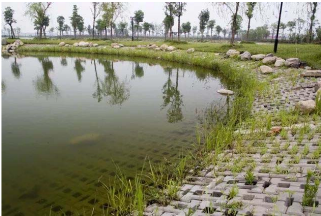
图1 自嵌式生态挡土墙
