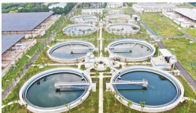
图1 污水处理厂提标改造工程
