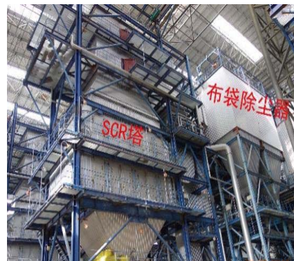
图5 焚烧后烟气净化系统示意图
