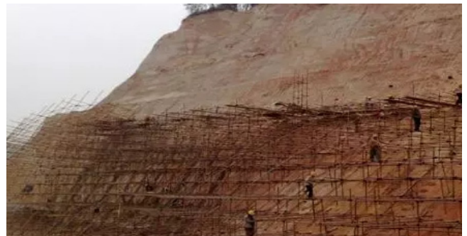
图1 锚杆支护现场图
