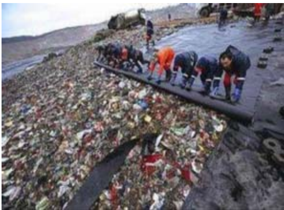
图1 垃圾覆盖工作
